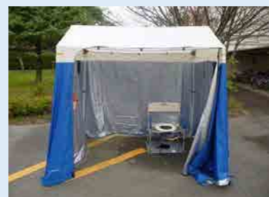
マンホールトイレ
