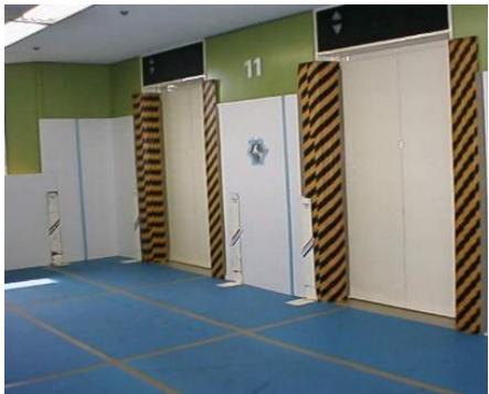
エレベーターホール付近
