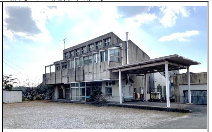
現況写真 (建物外観) ③
