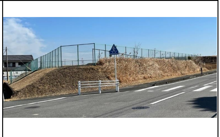
現況写真 ①
