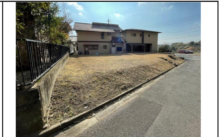
現況写真 ①
