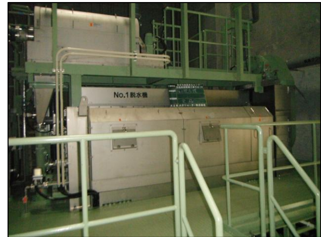
▲汚水処理設備の更新（汚泥脱水機）
