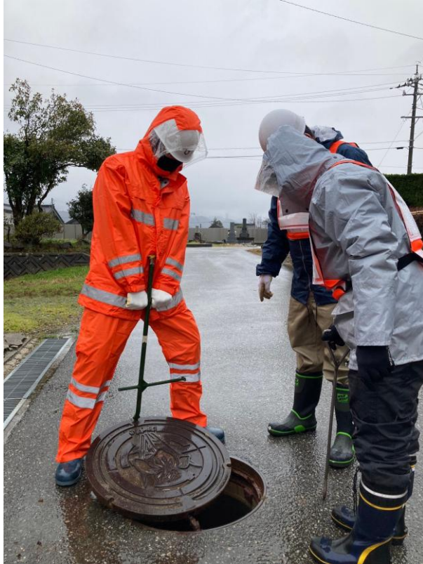
▲下水道点検の様子 (知多市職員派遣)
