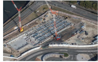
▲建設中の新庁舎の様子
