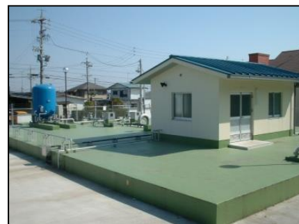
粕谷台ポンプ場
