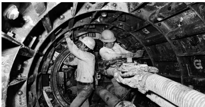
大型の掘削機で地下をトンネルのように掘り進める下水道工事の様子（昭和58年撮影）
