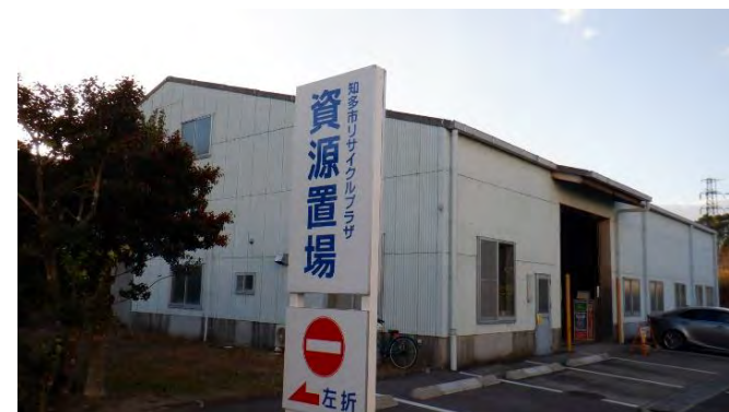
▲ リサイクルプラザ資源置場
