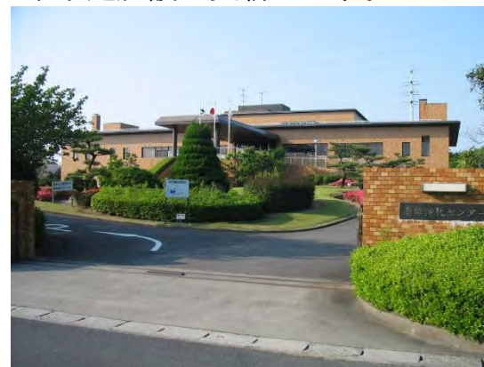
< 南部浄化センター >
