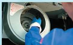
換気扇分解洗浄
