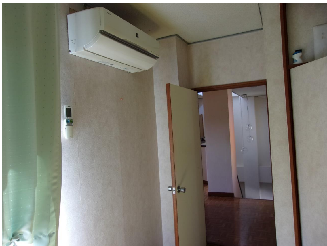
参考写真 2階洋室 残置されているエアコン
