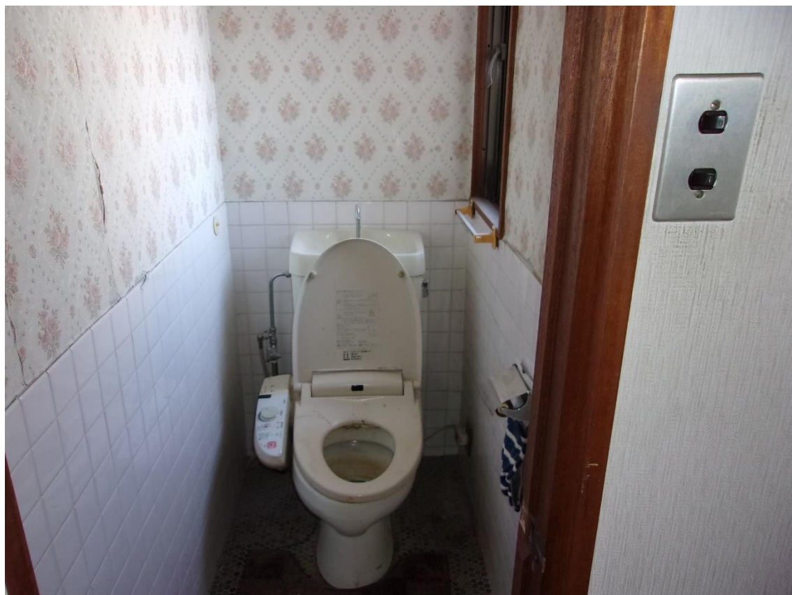
参考写真 1階トイレ
