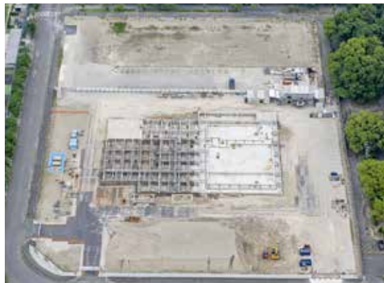
▲6月：基礎工事施工中
