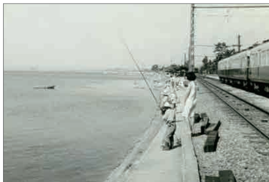
▲埋め立て工事が始まる前の朝倉駅付近
