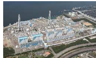
碧南火力発電所
