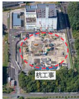
③ 9月～ 杭工事
