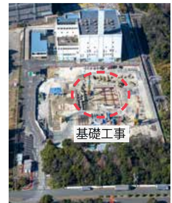
④ 12月～基礎(掘削)工事
