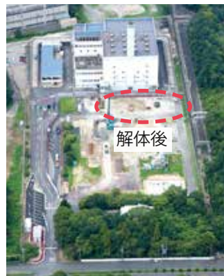
② 8月 知多市清掃センター 管理棟解体
