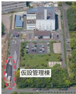
① 3年3月 仮設管理棟完成
