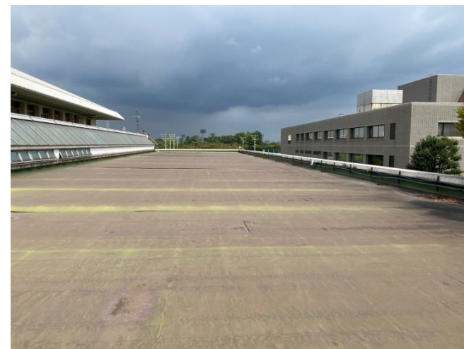
▲ 現在の武道棟屋上部分の様子
