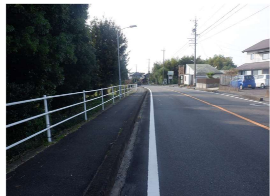
7 対応中 ガードレールの設置
