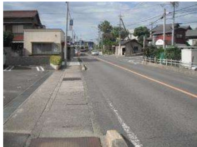
3 対応済 側溝蓋修繕
