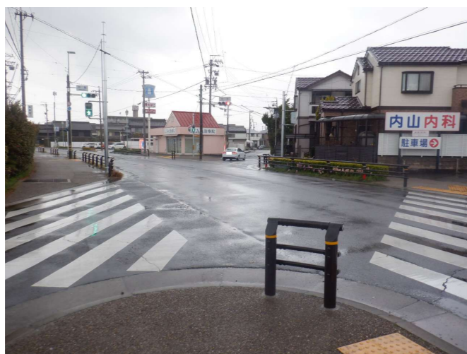
18 対応済 防護柵の設置
