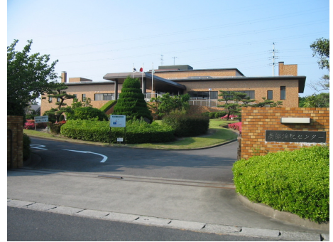
南部浄化センター(管理棟)
