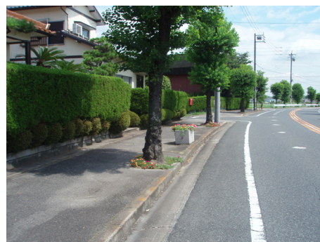
幹線道路の緑化の事例
