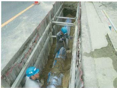
耐震管 φ500 布設状況
