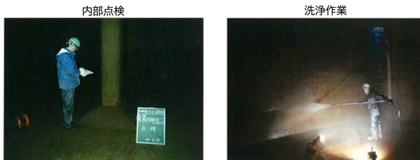
配水池内部の点検・清掃の様子
