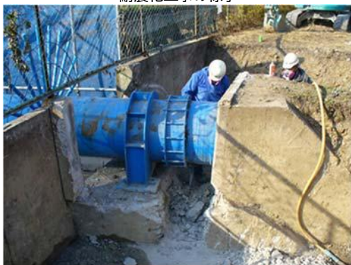
耐震化工事の様子
