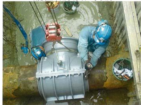
耐震型不断水分岐工事状況
