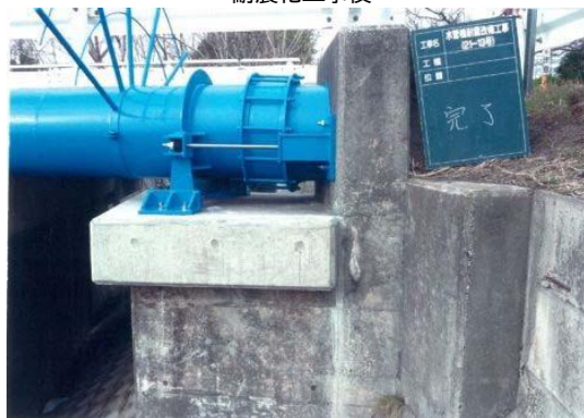
耐震化工事後
