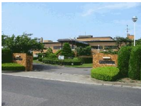
南部浄化センター
