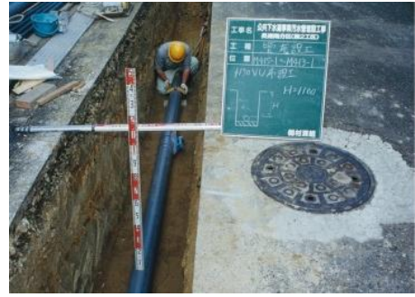
汚水管渠布設状況
