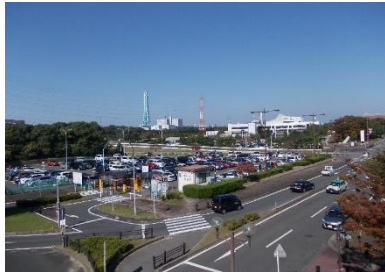
■朝倉駅前広場・駅前有料駐車場
