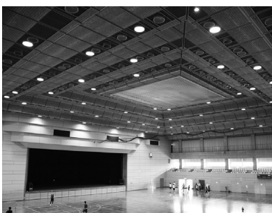
▲天井などが改修されるメディアス体育館ちた（市民体育館）
