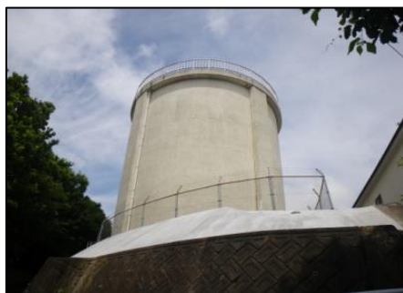
笹廻間配水塔
