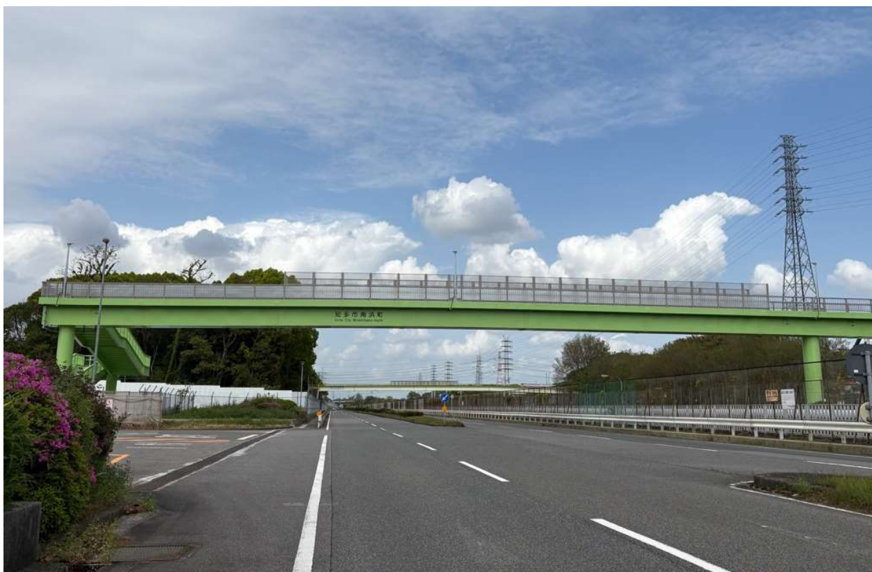
○長浦横断歩道橋（市道北浜金沢線及び国道155号・247号）
