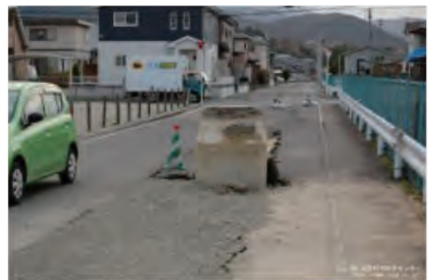
液状化により浮き上がったマンホール（東日本大震災）
