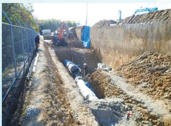
▲老朽化した配水管の布設替えの様子(丸根配水場)
