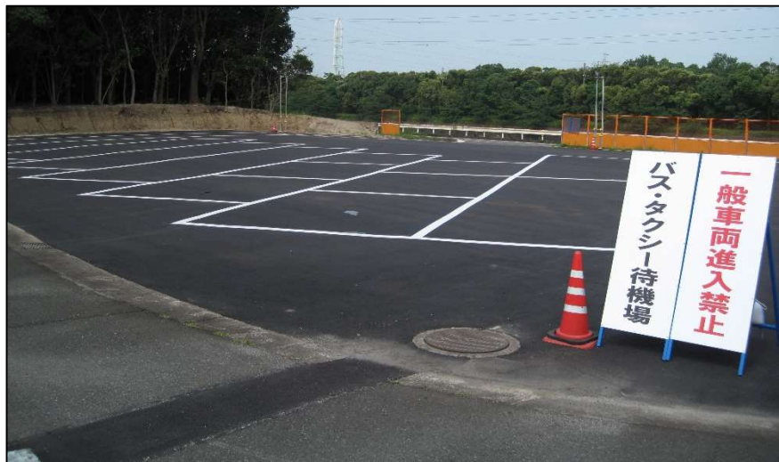
写真② バス・タクシー 仮設待機場
