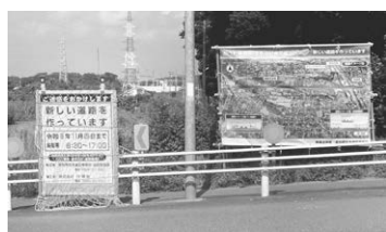
工事案内看板 (池下調整池南側の丁字路交差点)
