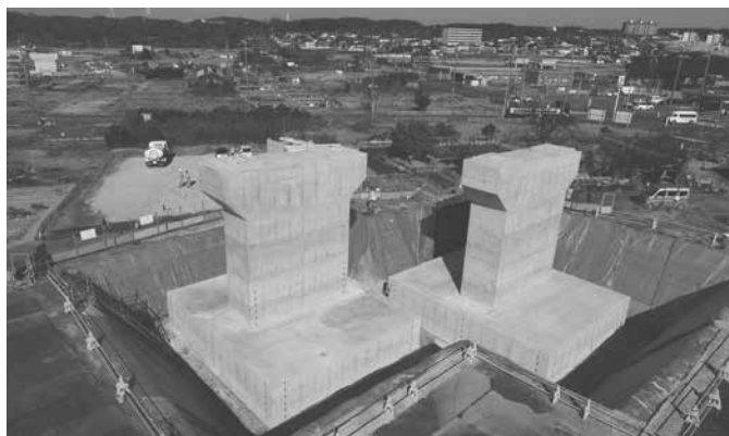
西知多道路の工事の様子
