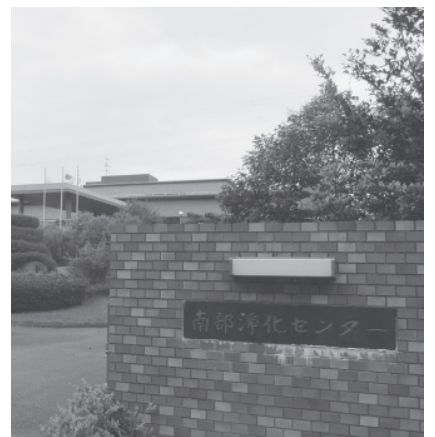
終末処理場南部浄化センター
