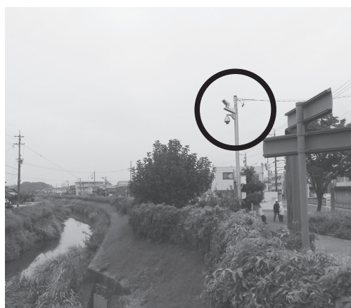
長曽橋の防災カメラ
