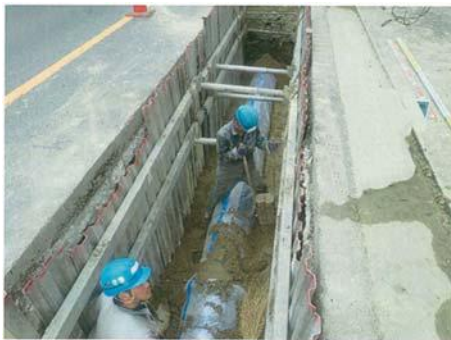
耐震管 φ500 布設状況
