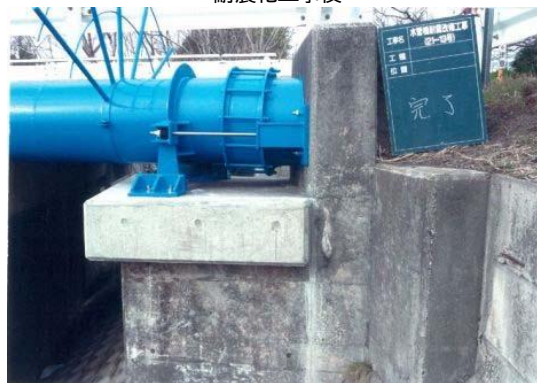
耐震化工事後
