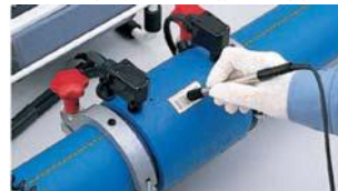
電気融着による継手接合
