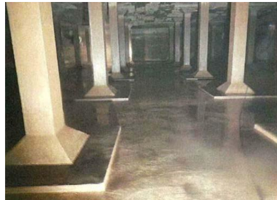
配水池写真(内観)
