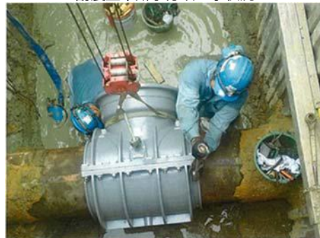
耐震型不断水分岐工事状況
