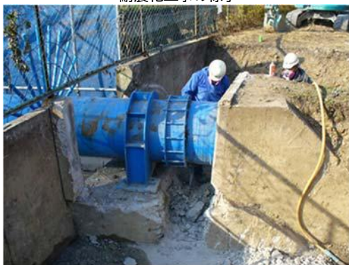
耐震化工事の様子
