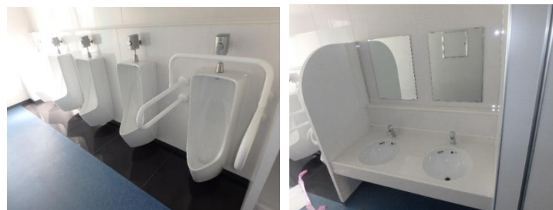
▲トイレ改修状況
