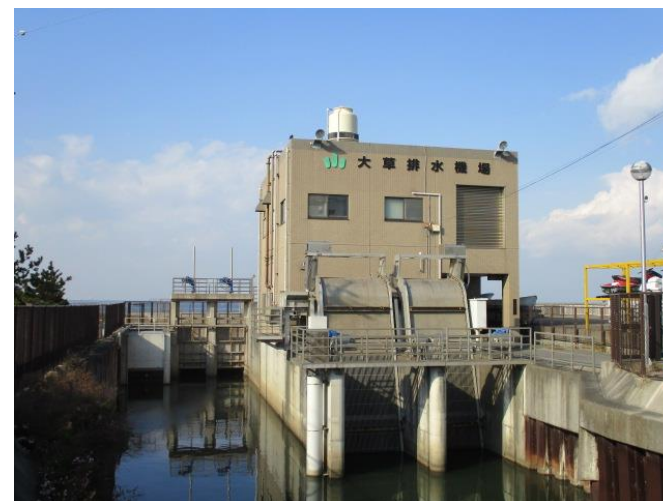
▲大草排水機場
