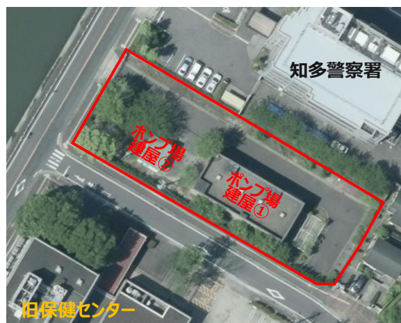
西部中継ポンプ場
