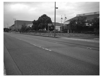
▲市道の舗装工事
