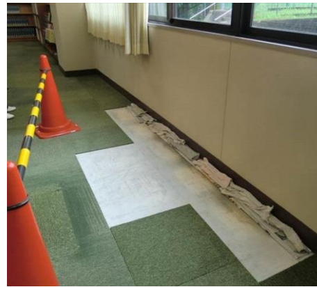
雨漏りへの対応の様子①
