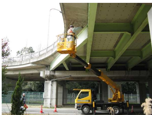
写真-3.1 専門業者による点検状況①
