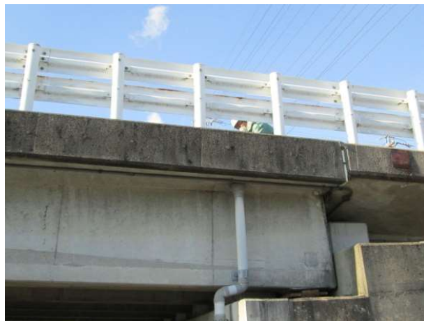
写真-3.3 職員による点検状況
