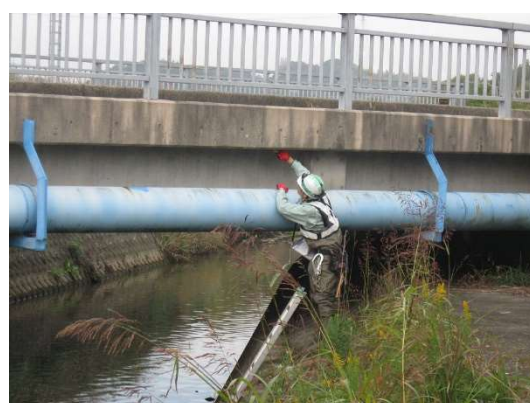
写真-3.2 専門業者による点検状況②
