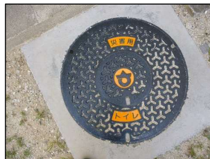
【専用マンホール】
