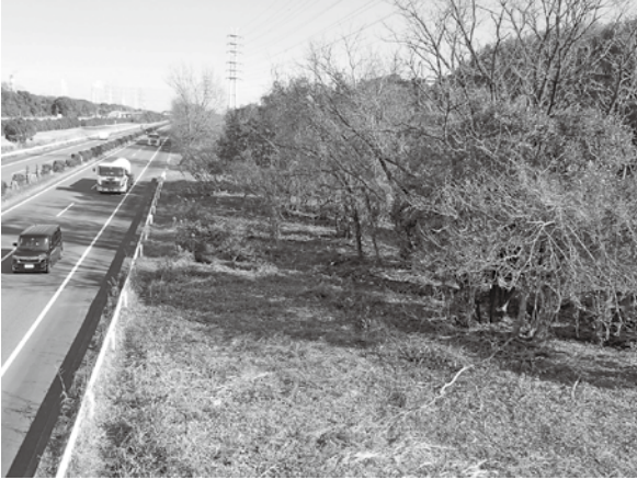
工事予定地（長浦横断歩道橋から撮影）
